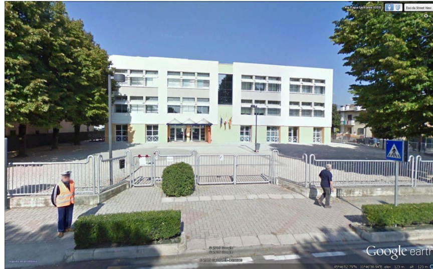
Ristrutturazione Scuole Elementari e Medie Esistenti.
