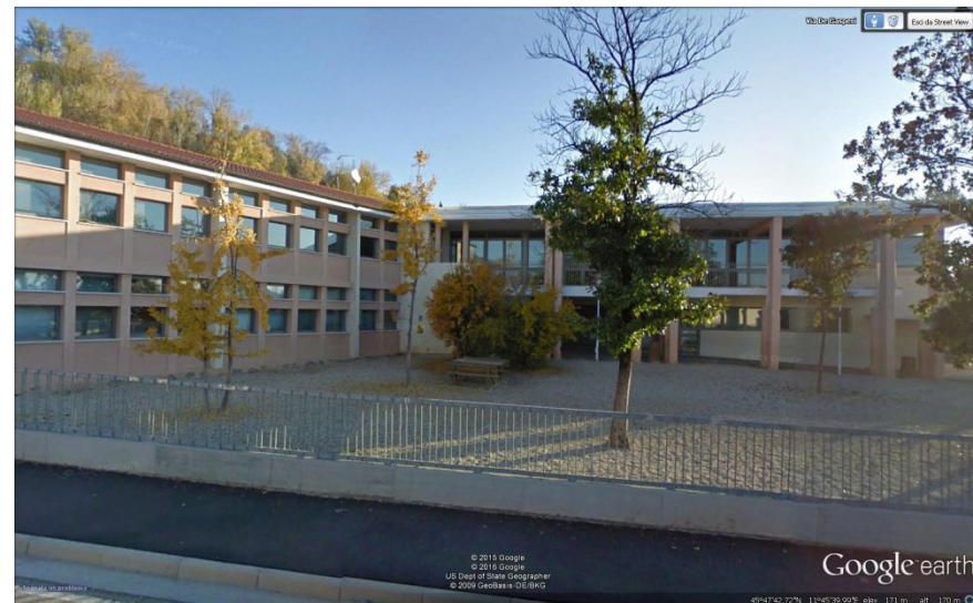
Nuovo Asilo Nido e Nuove Scuole Elementari .
