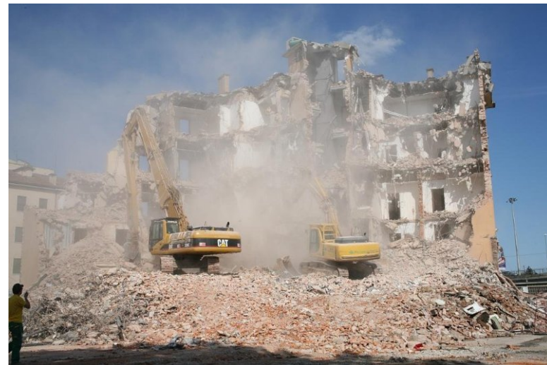
D.LL. CSE Demolizione edifici
