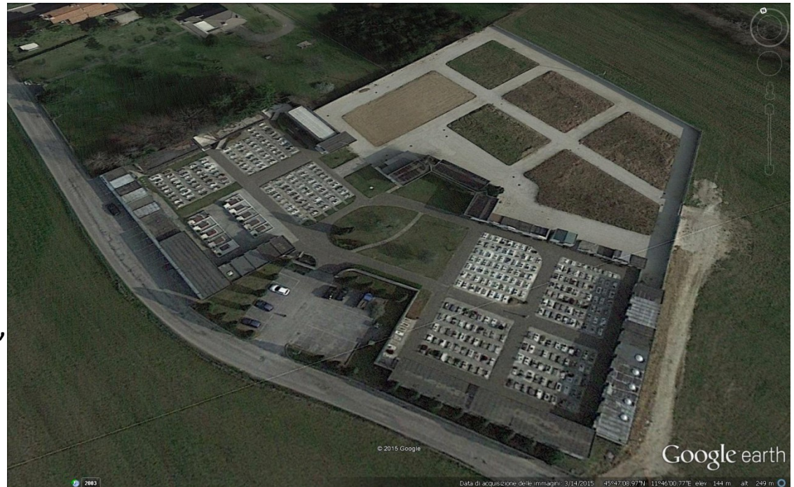
Interventi di Edilizia Cimiteriale.
