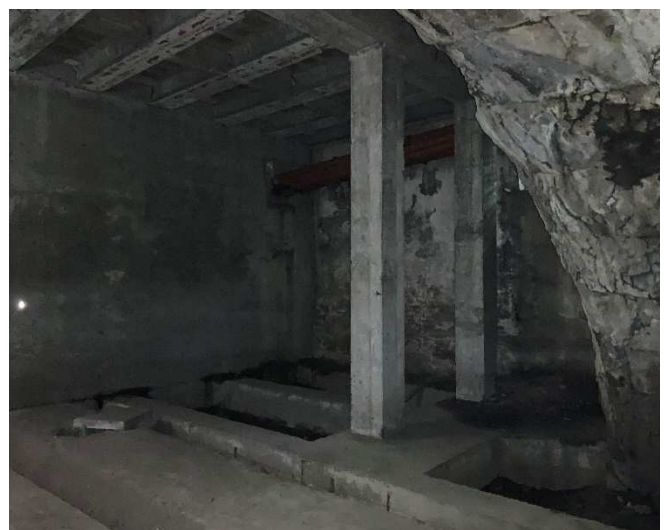
Vista della porzione nord del sottopassaggio Altinate
