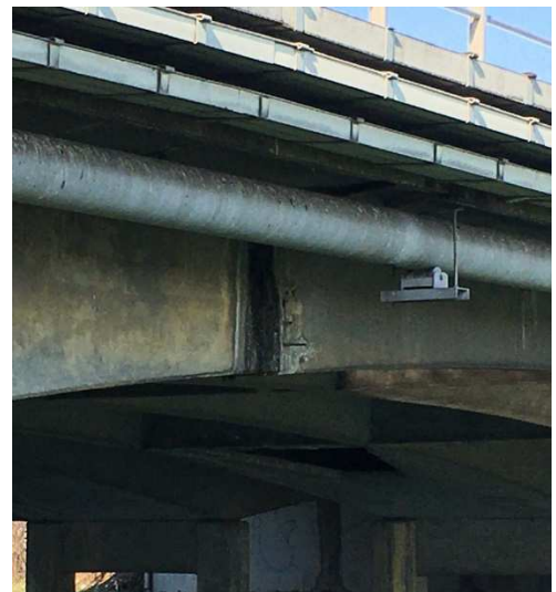
Esposizione delle barre d'armatura nella sella Gerber
