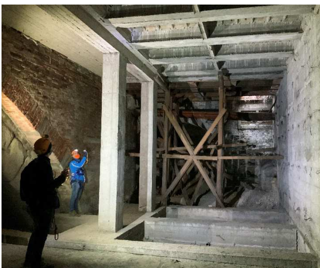
Vista della porzione sud del sottopassaggio Altinate
