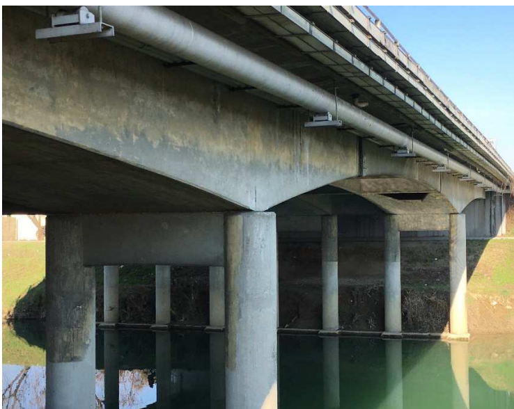
Vista a valle dell'impalcato
