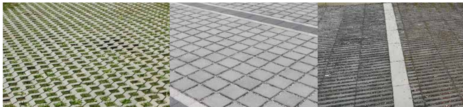
Figura 02.04. Esempi di pavimentazioni permeabili.
