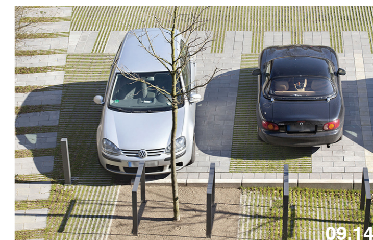
Schema 09.13. Diversi approcci per drenare, laminare e infiltrare le acque di pioggia ricadenti sui parcheggi con differenti livelli di servizi ecosistemici aggiuntivi forniti.
