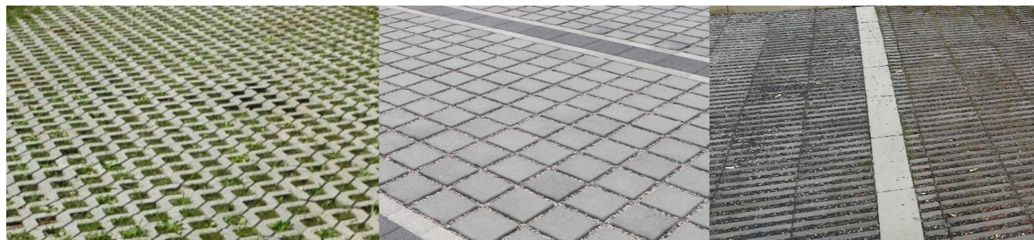
Figura 02.04. Esempi di pavimentazioni permeabili.
