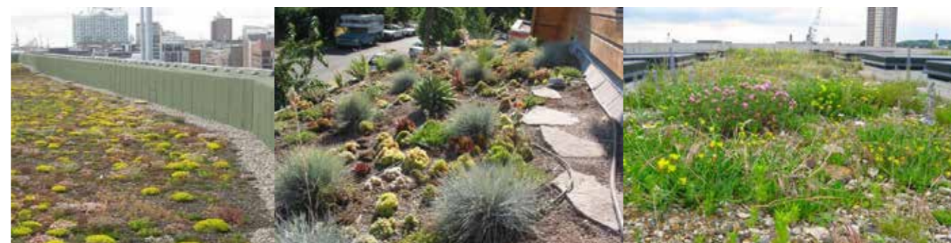
Figura 02.07. Esempi di tetti verdi estensivi.
