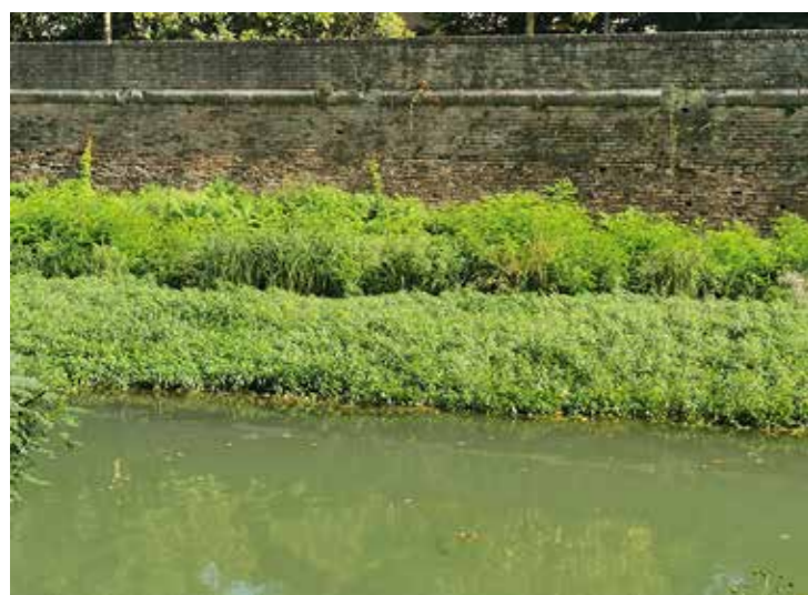
Figura 01.10. La vegetazione acquatica lungo il Tronco Comune in via Goito.
