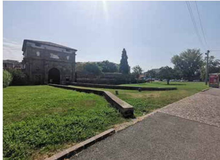
Figura 01.22. Le aree verdi di fronte alla Porta San Giovanni
