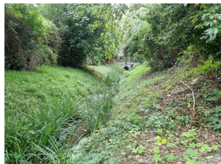
Figura 07.02.14. La canaletta Brusegana nell'ultimo tratto prima del tombinamento, dove non arrivano i mezzi del Consorzio.
