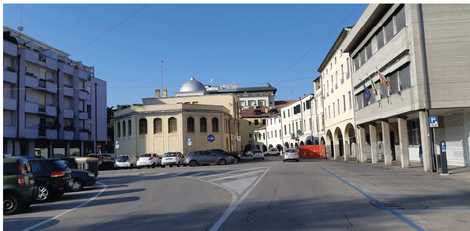
Intersezione Piazzale Mazzini con Viale della Rotonda
