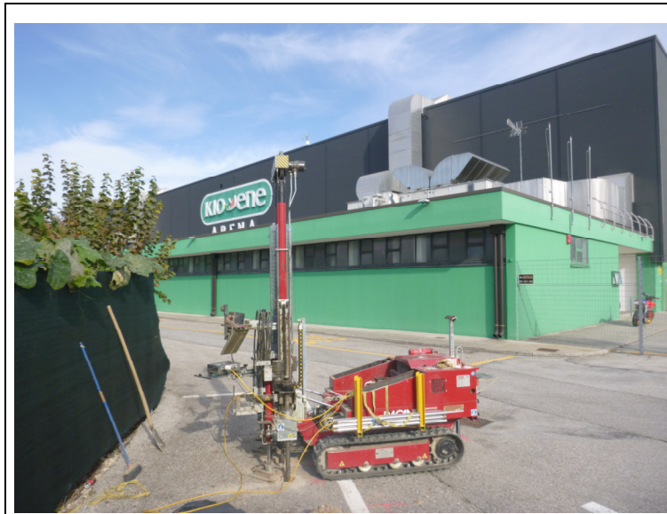
Esecuzione della prova CPTU3
