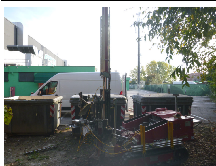
Esecuzione della prova CPTU1
