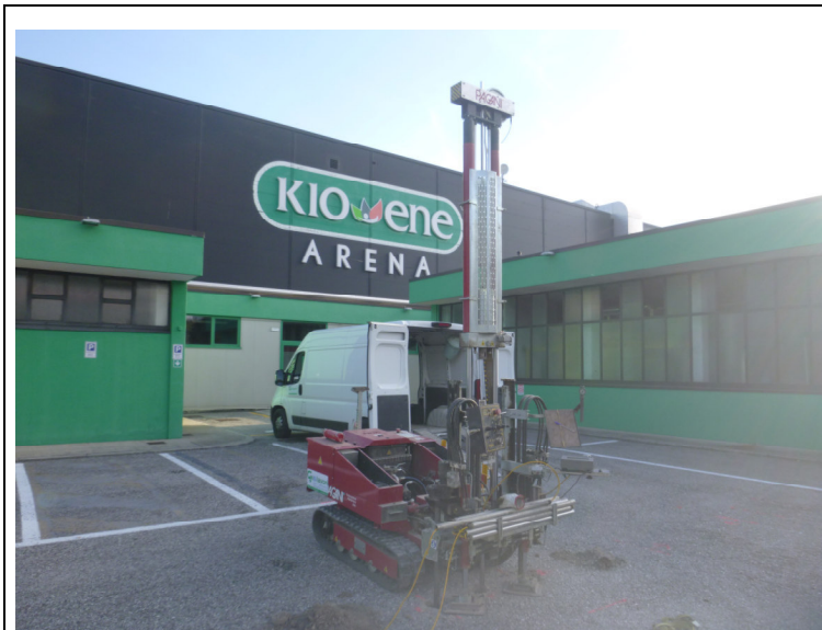
Esecuzione della prova CPTU2
