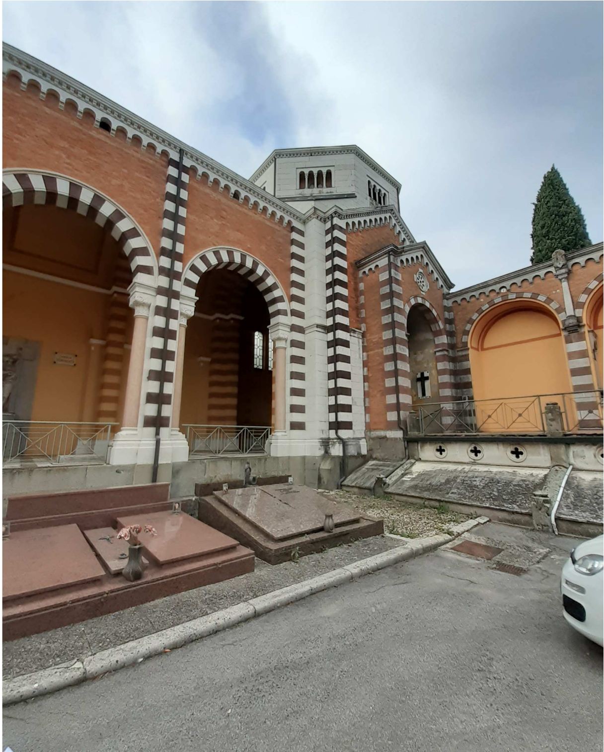
2 Vista esterna parte terminale della Galleria di Ponente
