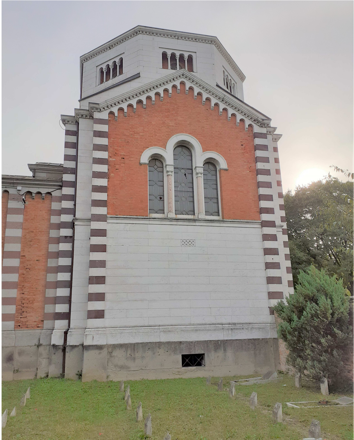
1 Vista esterna parte terminale della Galleria di Ponente
