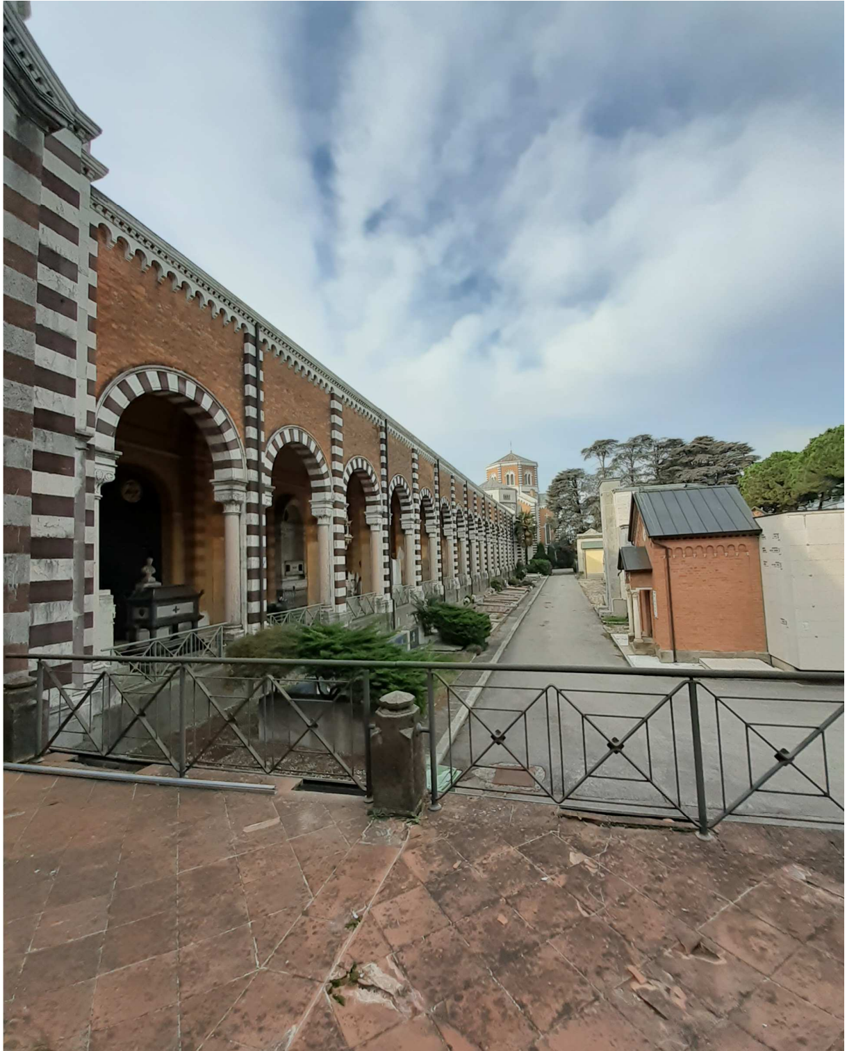
23 Vista esterna Galleria di Levante
