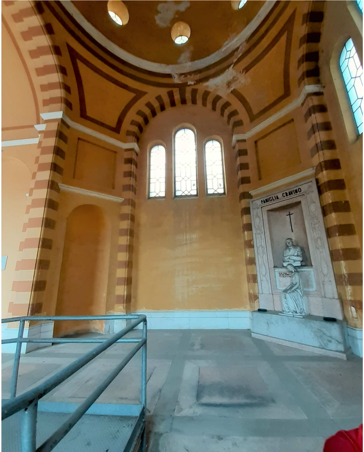
6 Vista interna parte terminale della Galleria di Ponente
