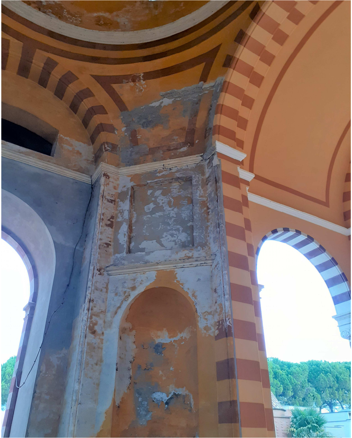
4 Vista interna parte terminale della Galleria di Ponente
