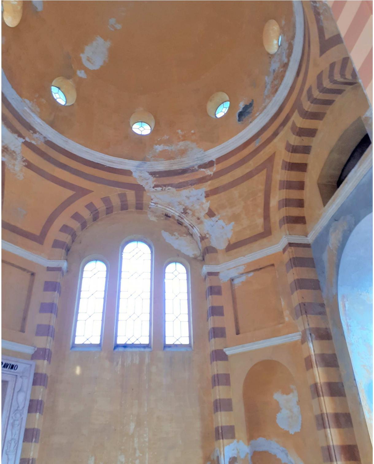
3 Vista interna parte terminale della Galleria di Ponente
