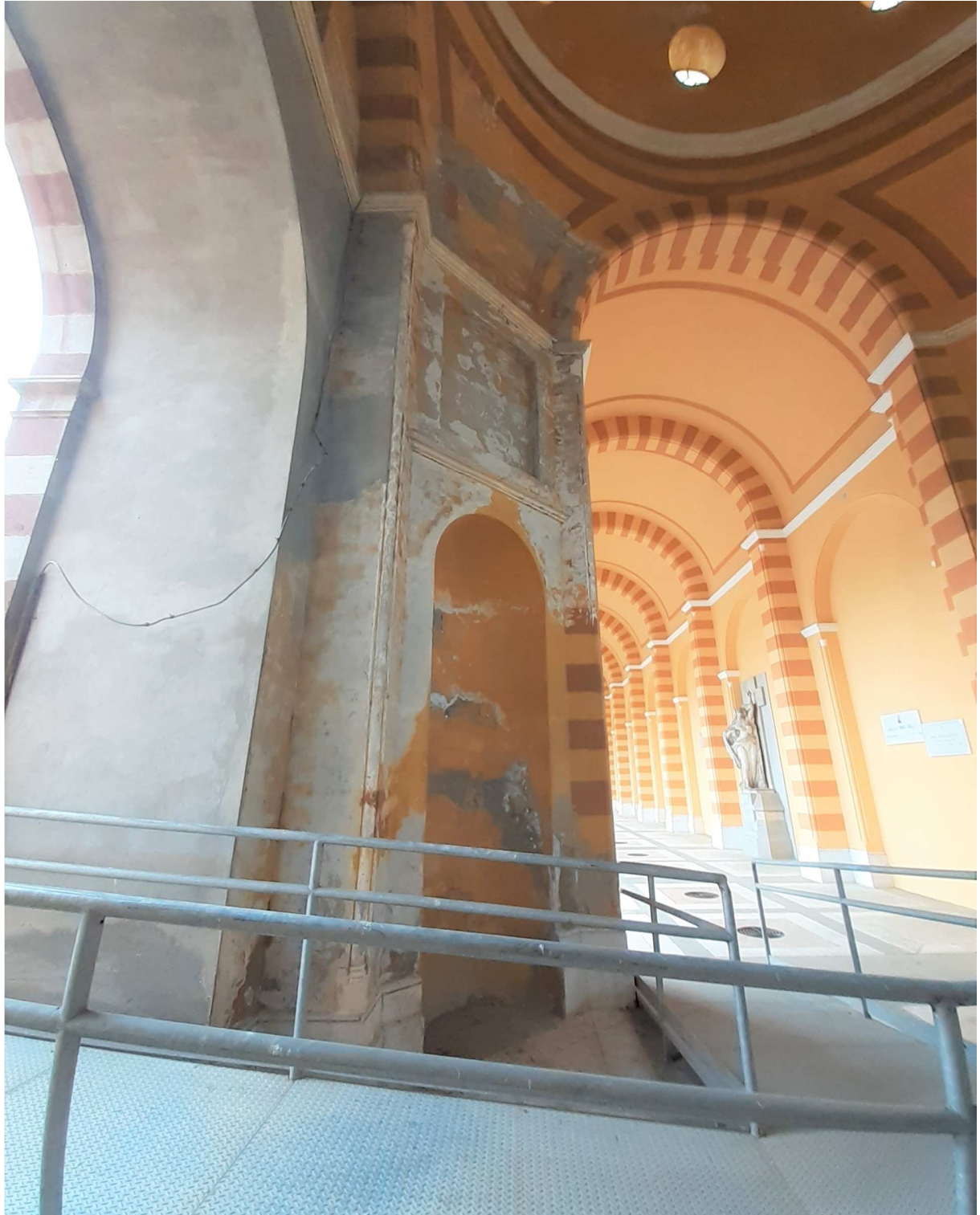
7 Vista interna parte terminale della Galleria di Ponente
