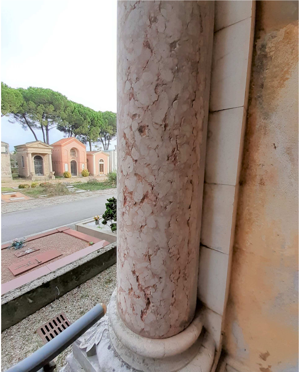
15 Vista interna Galleria di Levante
