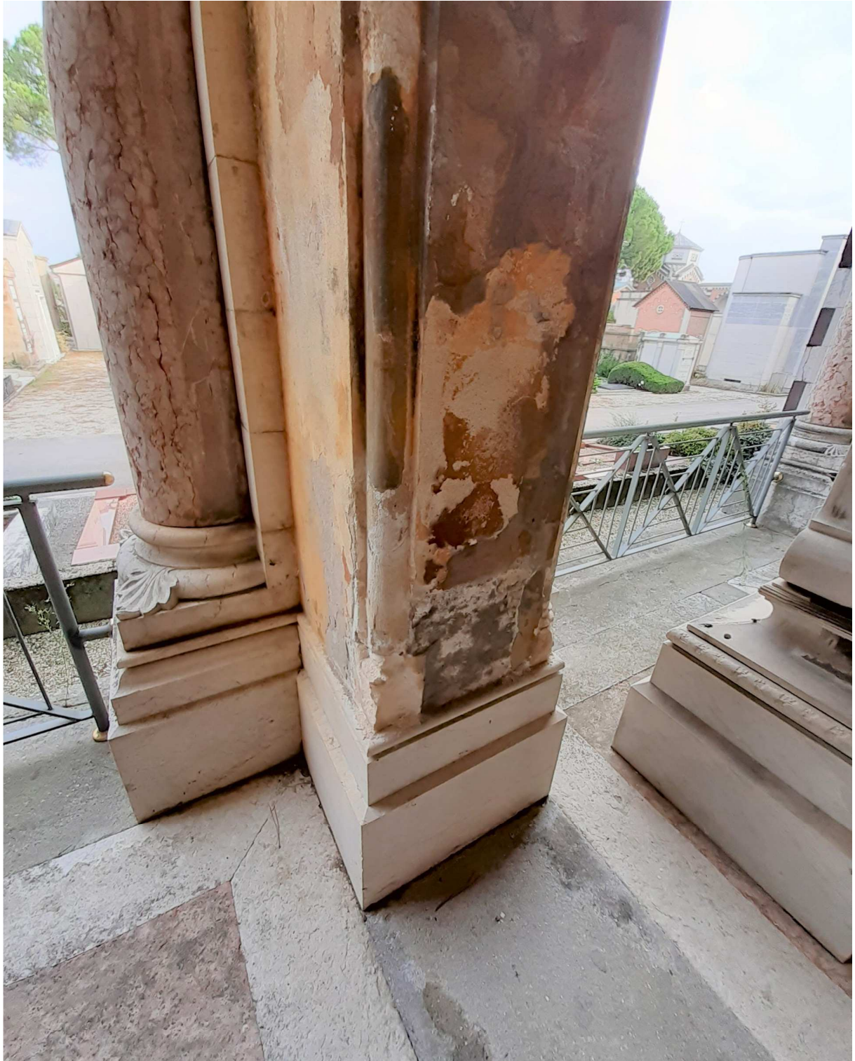
14 Vista interna Galleria di Levante
