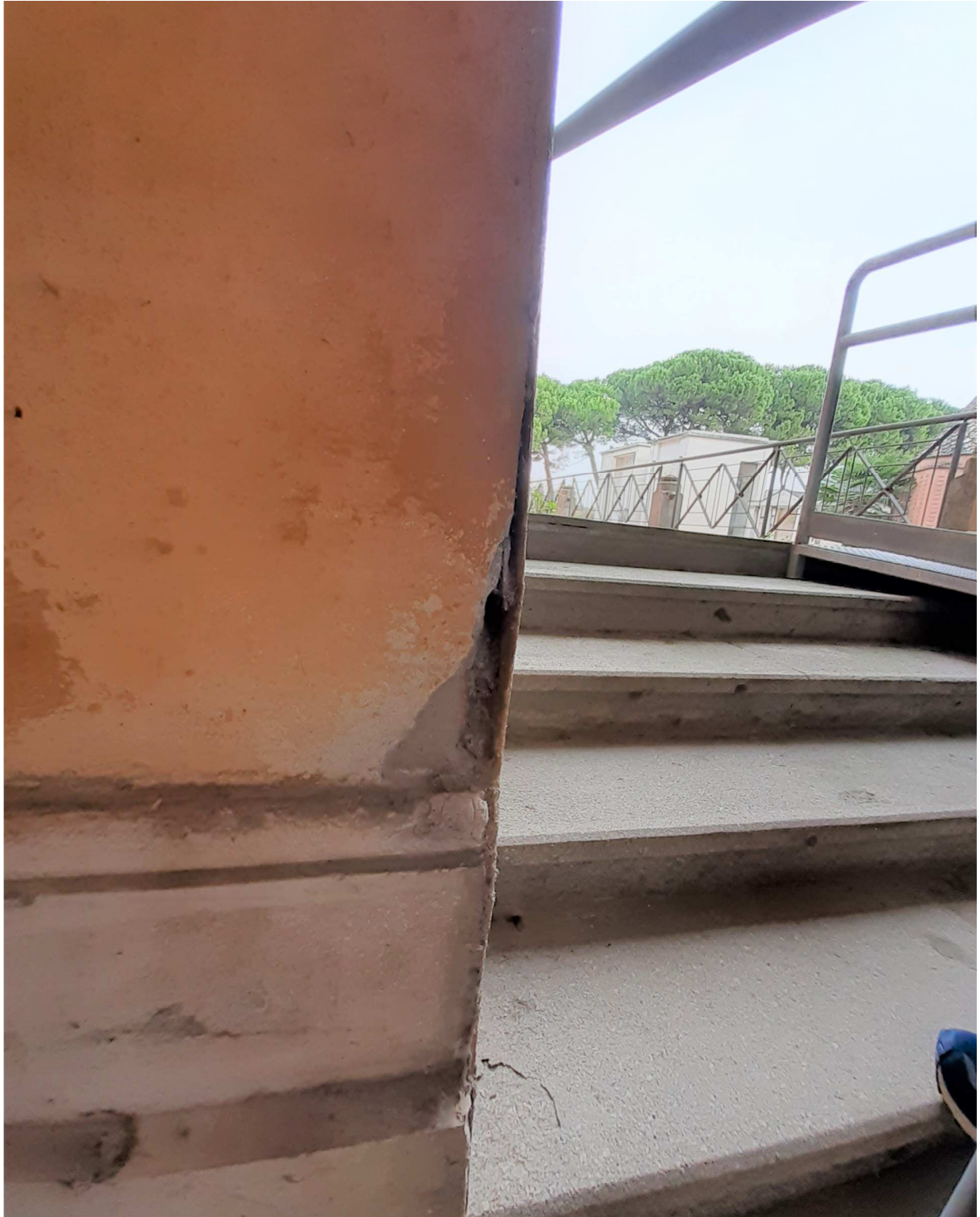
5 Vista interna parte terminale della Galleria di Ponente
