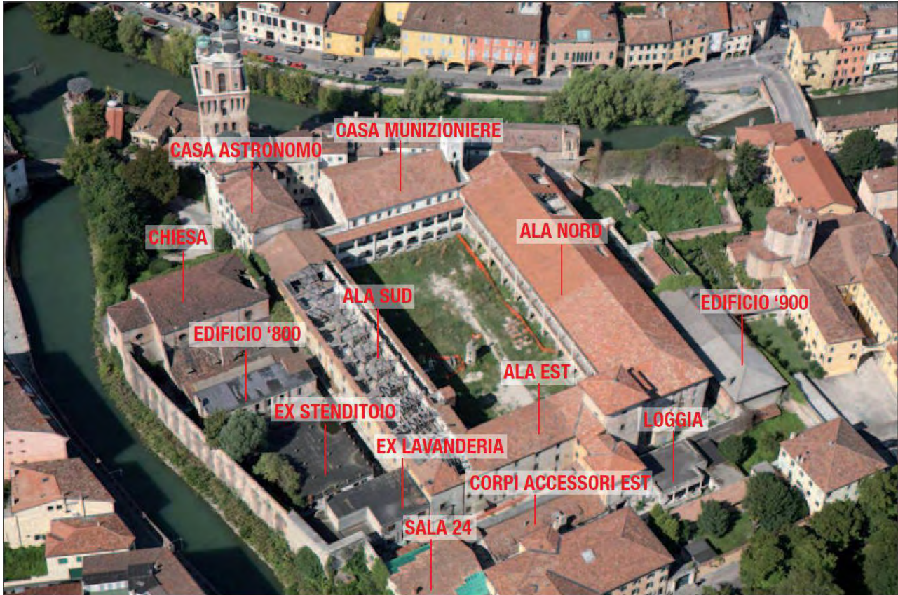
Foto aerea con indicazione dei corpi componenti il complesso del castello
