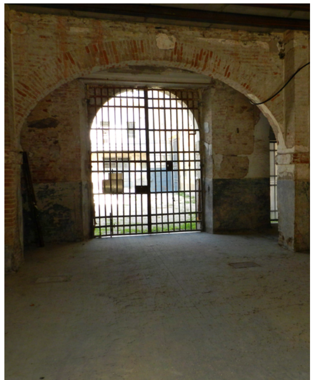
Ingresso a nord
