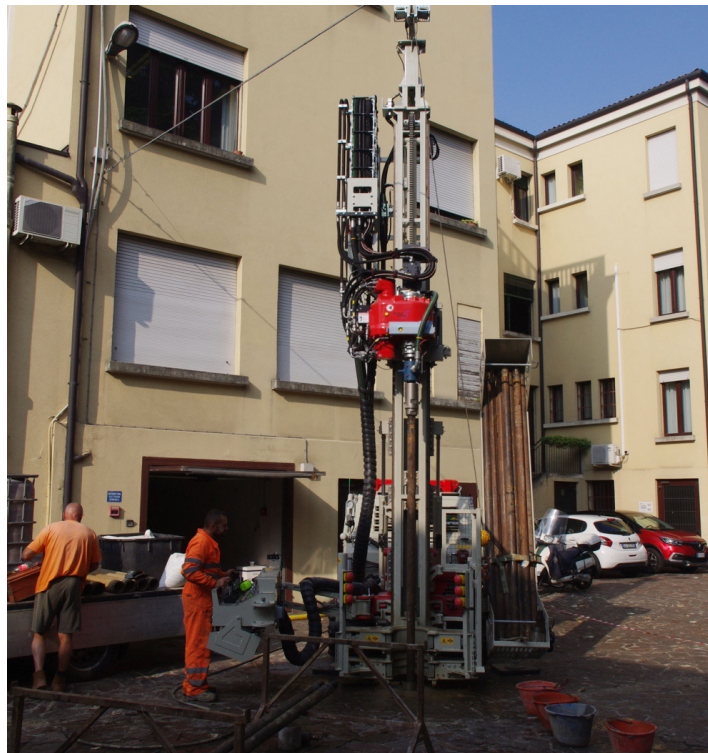
Fig. 4. Carotiere in azione per la perforazione S1 nella corte di via S. Eufemia
