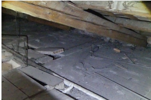
Figura 21 – Vista dei tavelloni del solaio sottotetto
