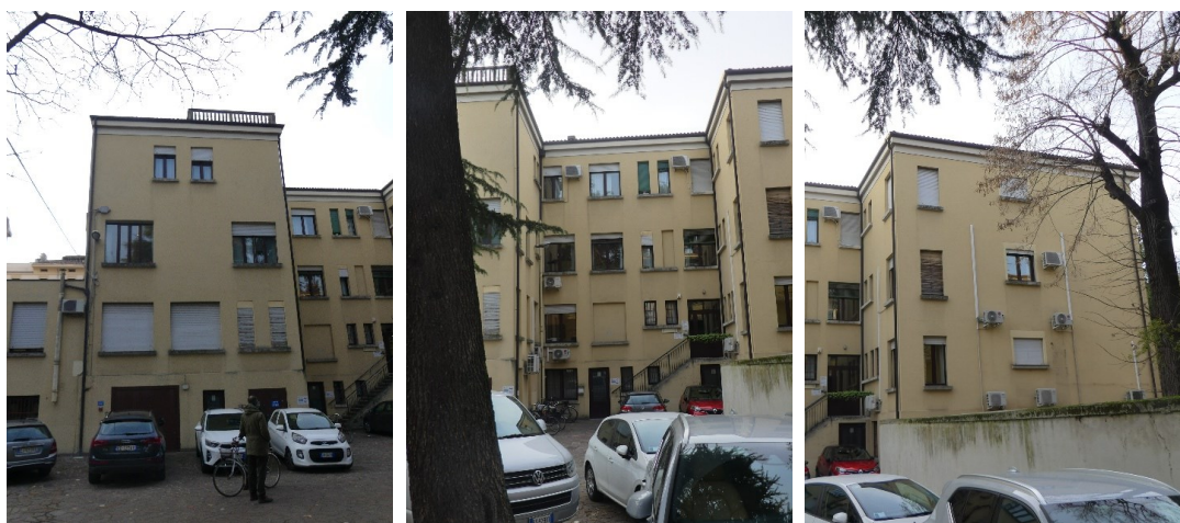
Figura 5 – Vista Prospetto Est da via Santa Eufemia
