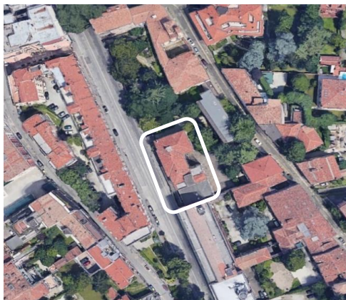
Figura 2: edificio in via Falloppio al n.17 e via Sant'Eufemia al n.8.
