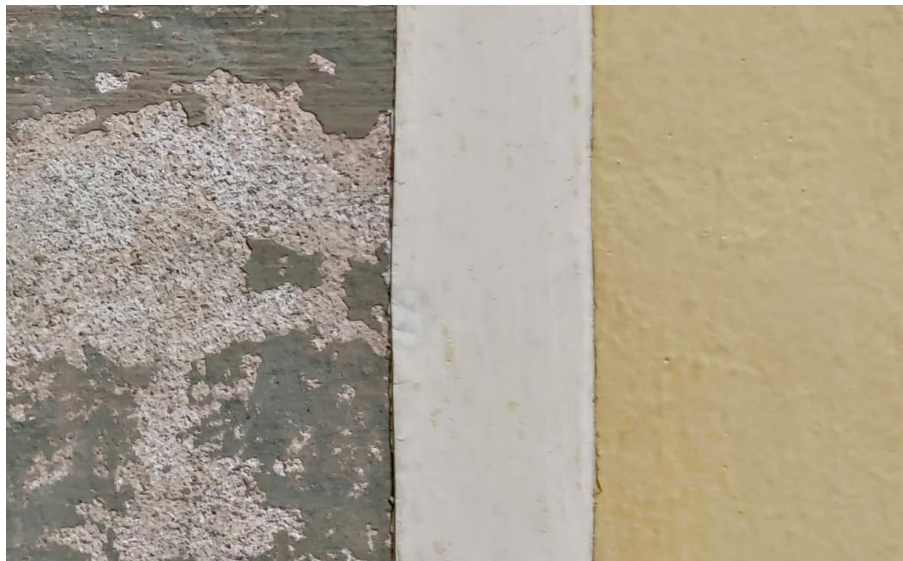
Figura 7: particolare delle coloriture eseguite direttamente su fondo grezzo (sx) e strato di ripristino con tinteggiatura di produzione moderna (dx); tassello 8 al piano secondo.
