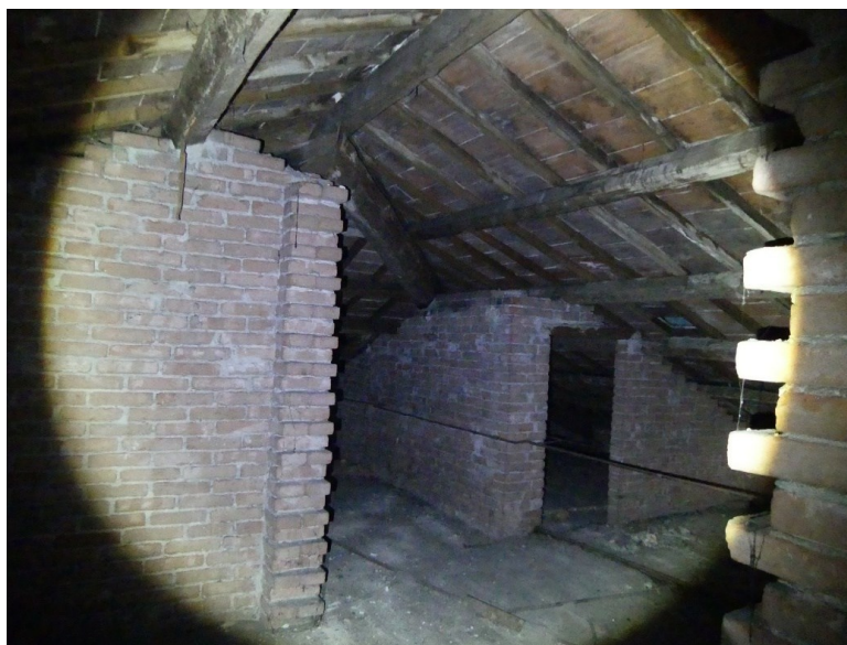
Figura 25 – Murature zona sottotetto
