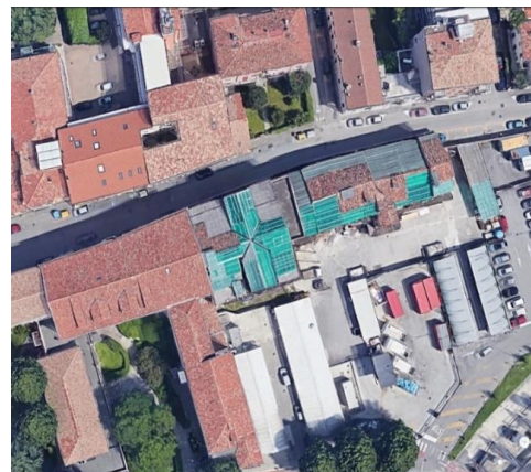
Figura 3: complesso denominato "casette".
