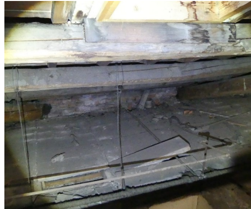
Figura 21 – Vista dei tavelloni del solaio sottotetto
