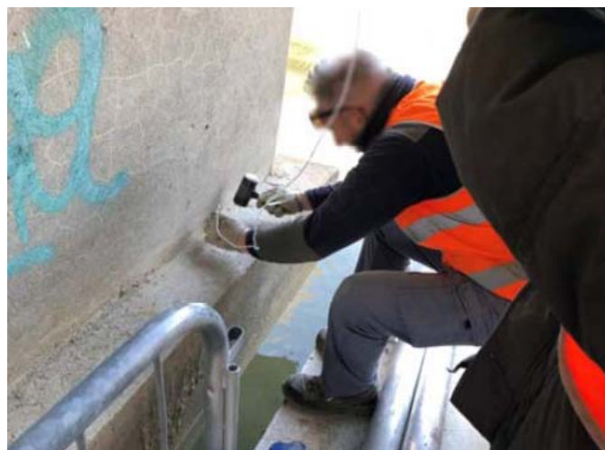
Prova ecometrica sui pali di fondazione
