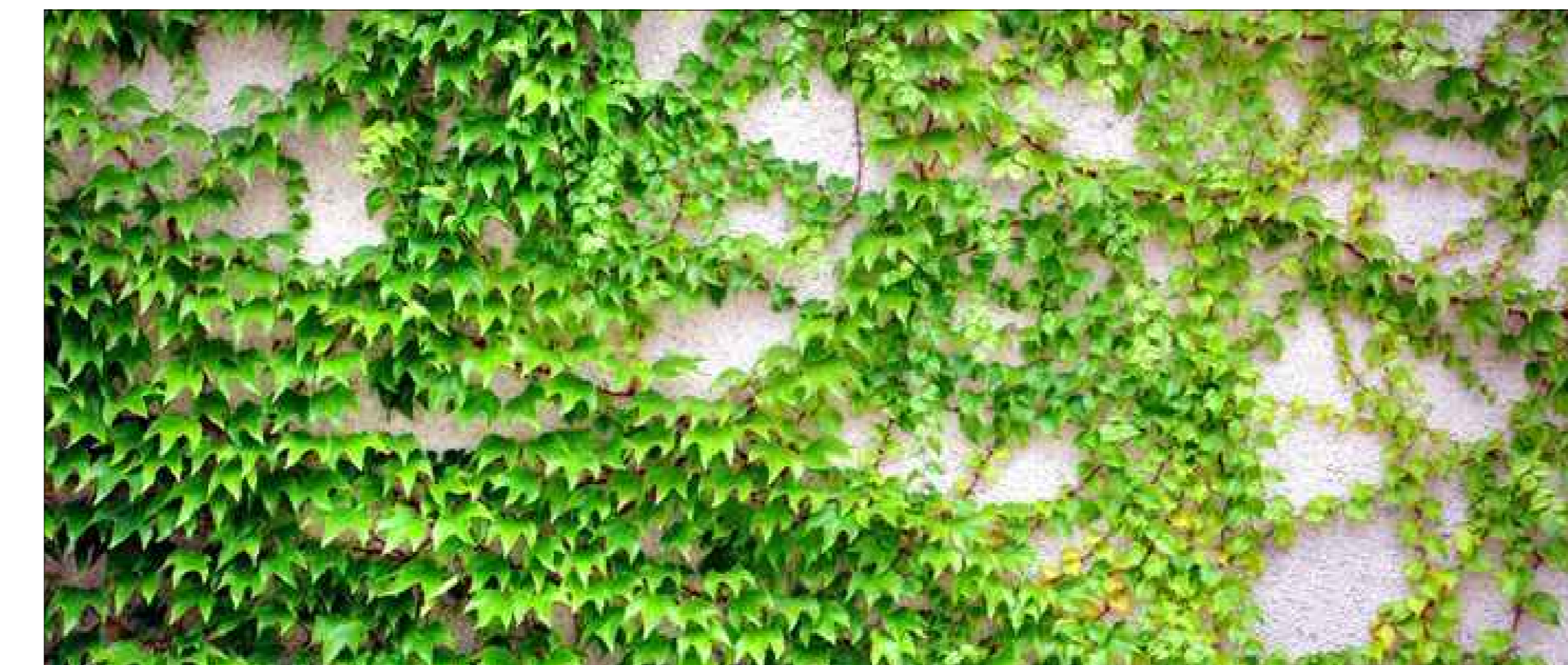
ESEMPIO DI MURO CON EDERA
