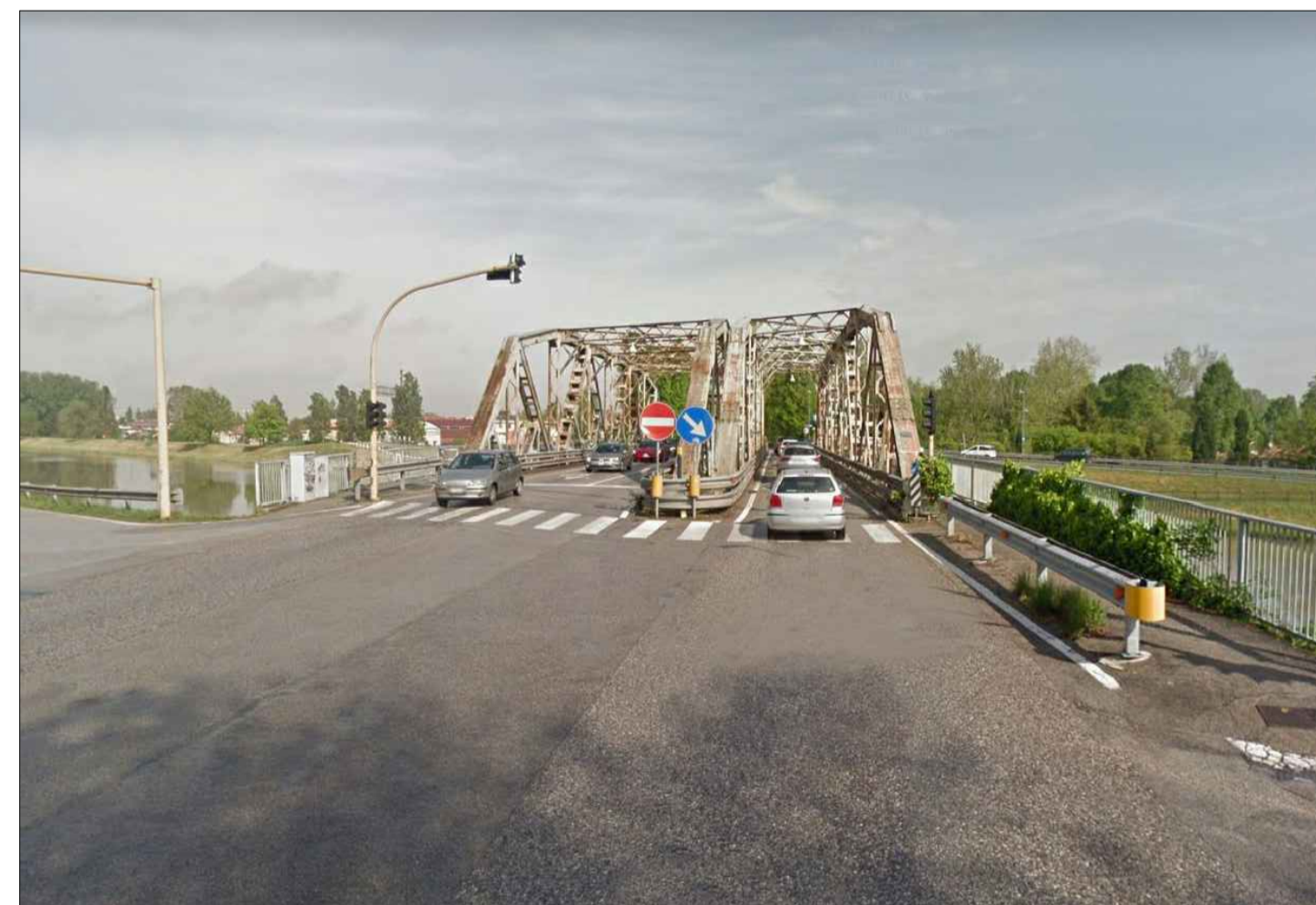
FOTO 5_DA VIA PIOVESE VERSO NUOVO PONTE CANALE SCARICATORE
