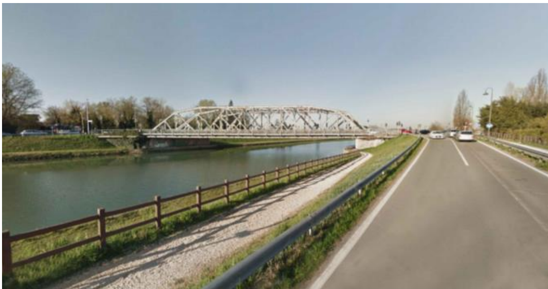
65. Vista del ponte esistente Ante opera
