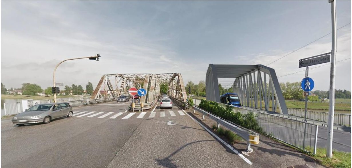
67. Vista prospettica lato sud
