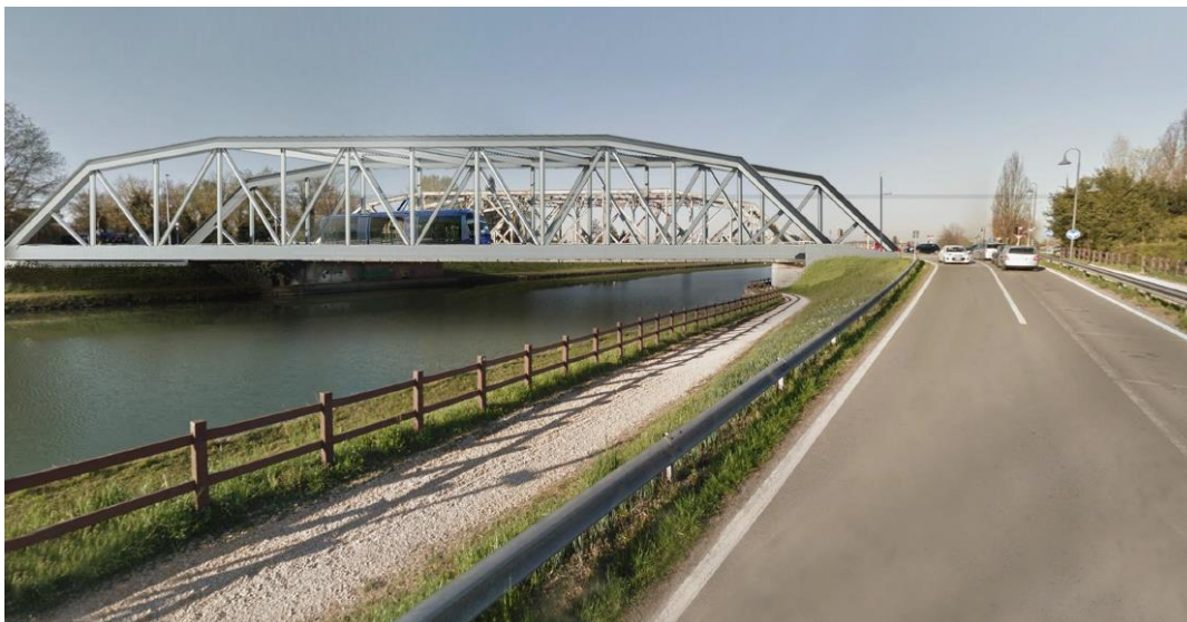
66. Vista del ponte esistente Post opera
