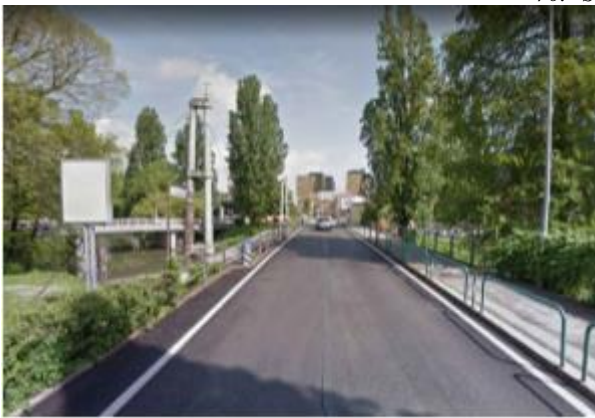
71. Ponte Omizzolo stato di fatto
