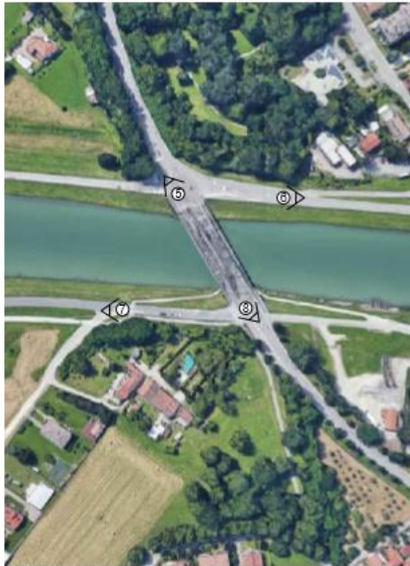
Inquadramento area del ponte su Fiume Bacchiglione con punti di vista fotografici
