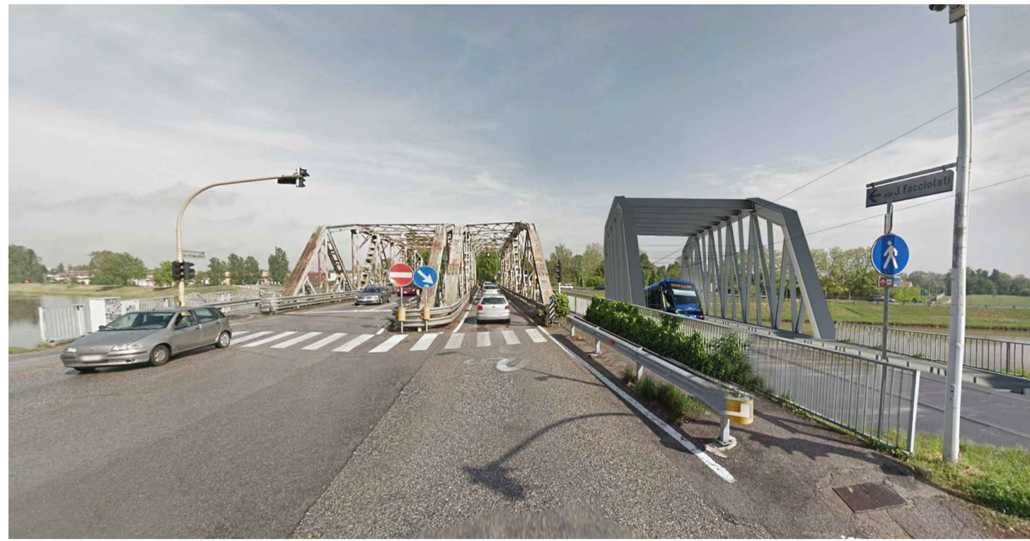
VISTA PROSPETTICA LATO SUD
