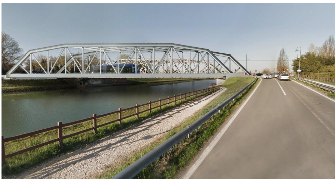
102. Vista del ponte esistente Post opera
