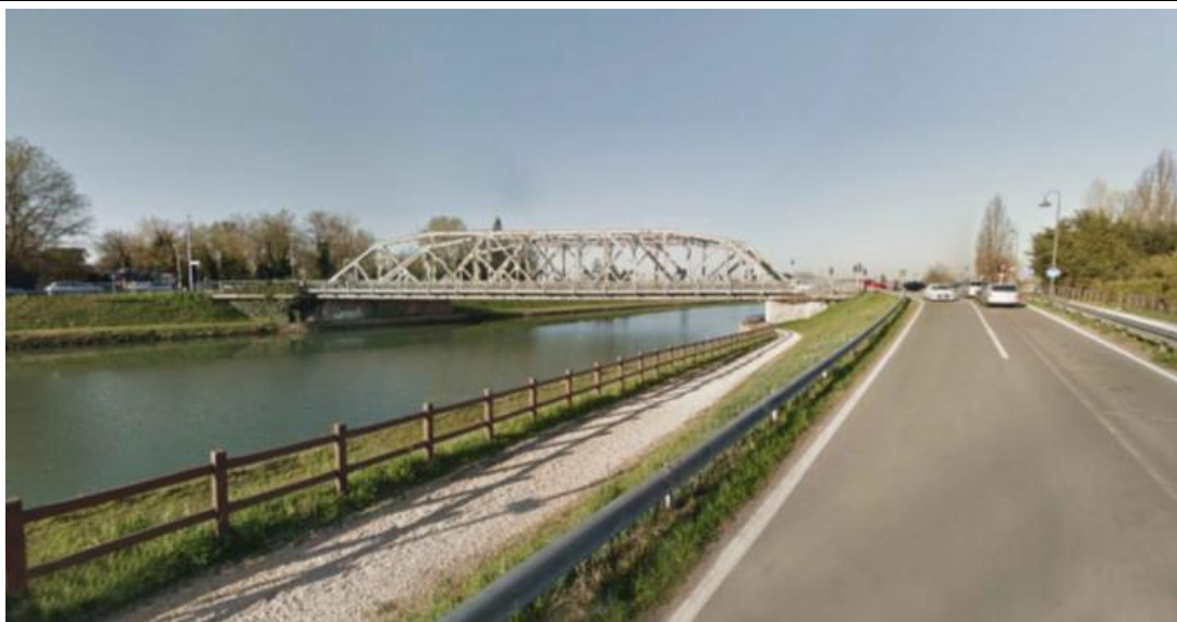
101. Vista del ponte esistente Ante opera
