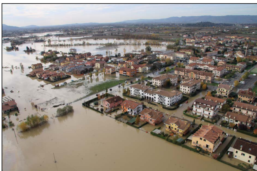
11. Effetti dell'alluvione del 2010 in area della provincia di Padova - Veggiano - Fonte Progetto di Piano di gestione del rischio alluvioni-
