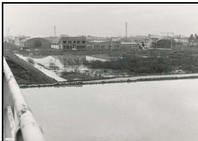
9. Piena storica del 1966- allagamento dell'area industriale padovana- fonte Rischi di inondazione nella provincia di Padova -L. D'Alpaos
