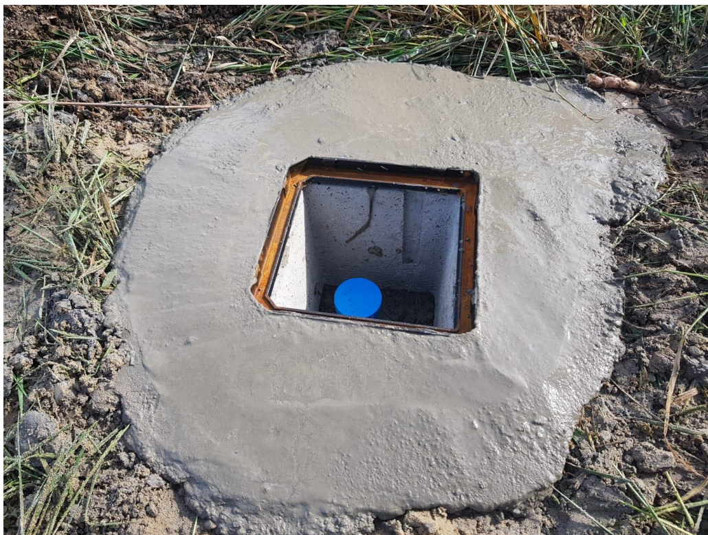
Figura 9 – Piezometro a tubo aperto installato nel sondaggio S1.
