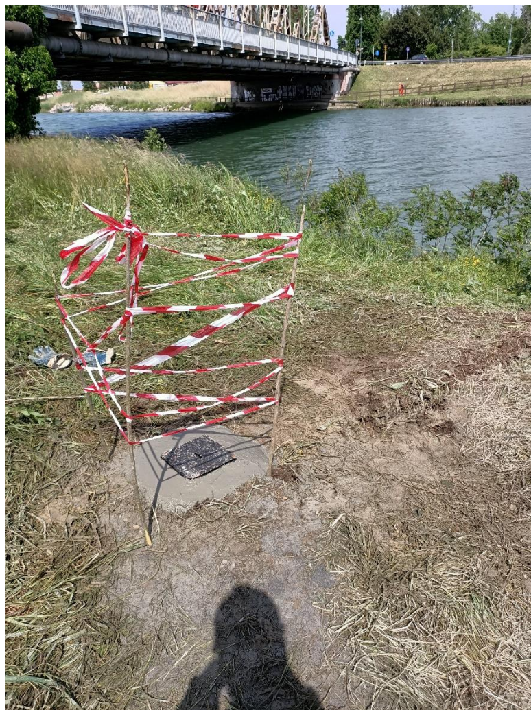
Figura 21 - Pozzetto carrabile in protezione del tubo piezometrico posto nel sondaggio S3.
