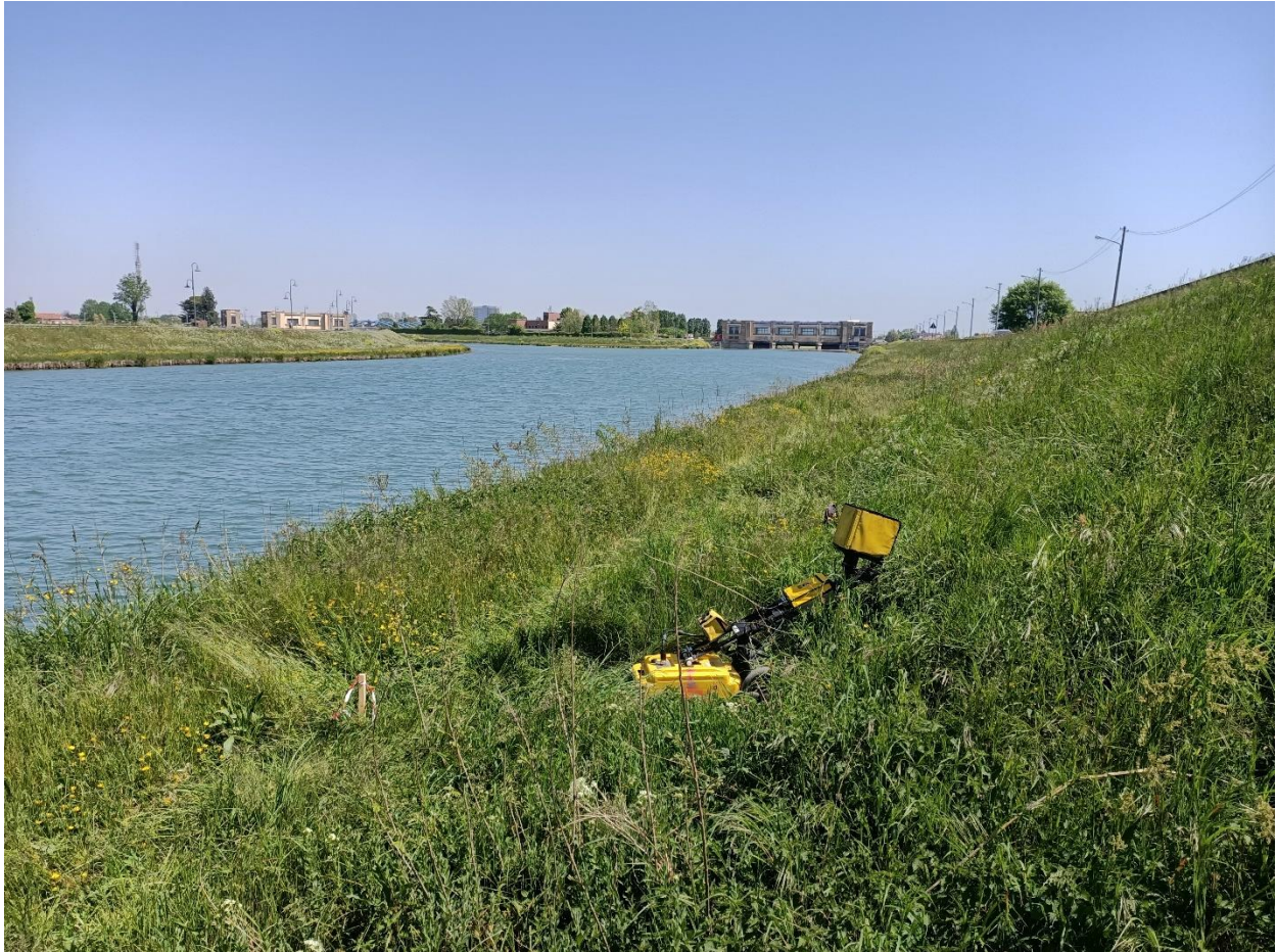
Figura 12 – Indagine georadar in corrispondenza del punto di sondaggio S3.
