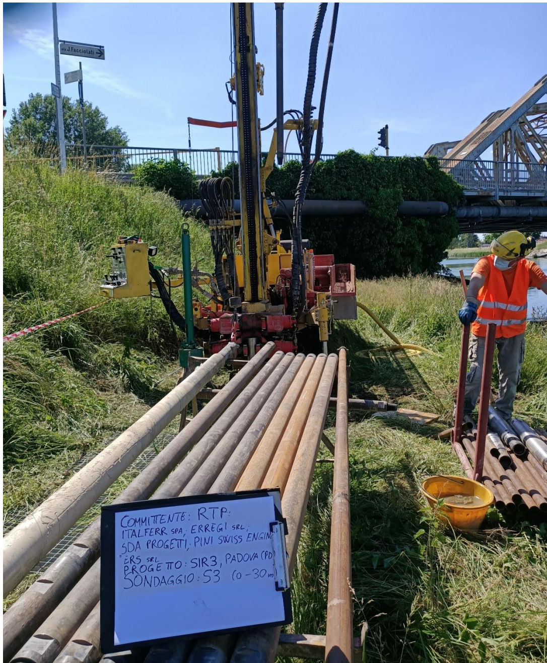
Figura 13 – Sonda approntata nel sondaggio S3
