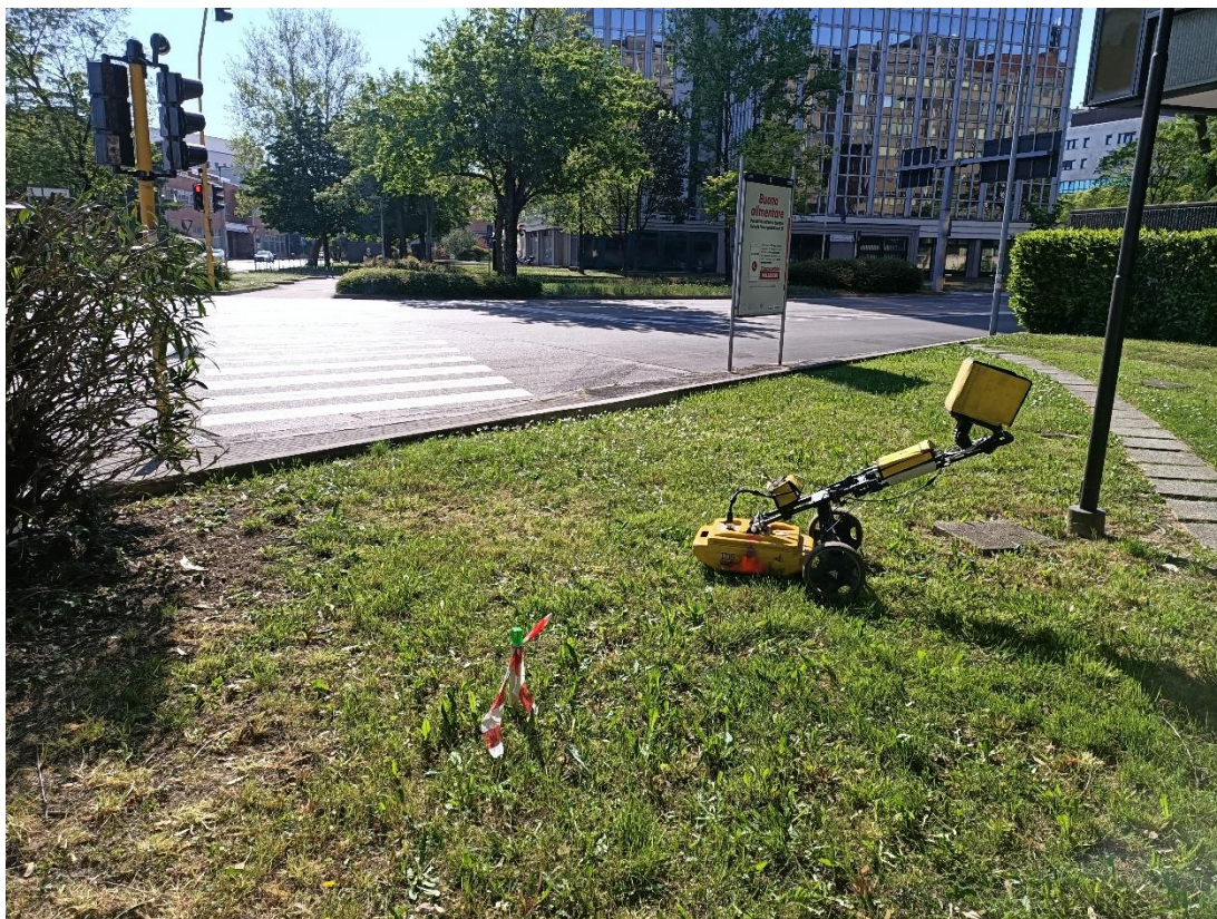
Figura 37 – Indagine georadar in corrispondenza del punto di indagine E1.
