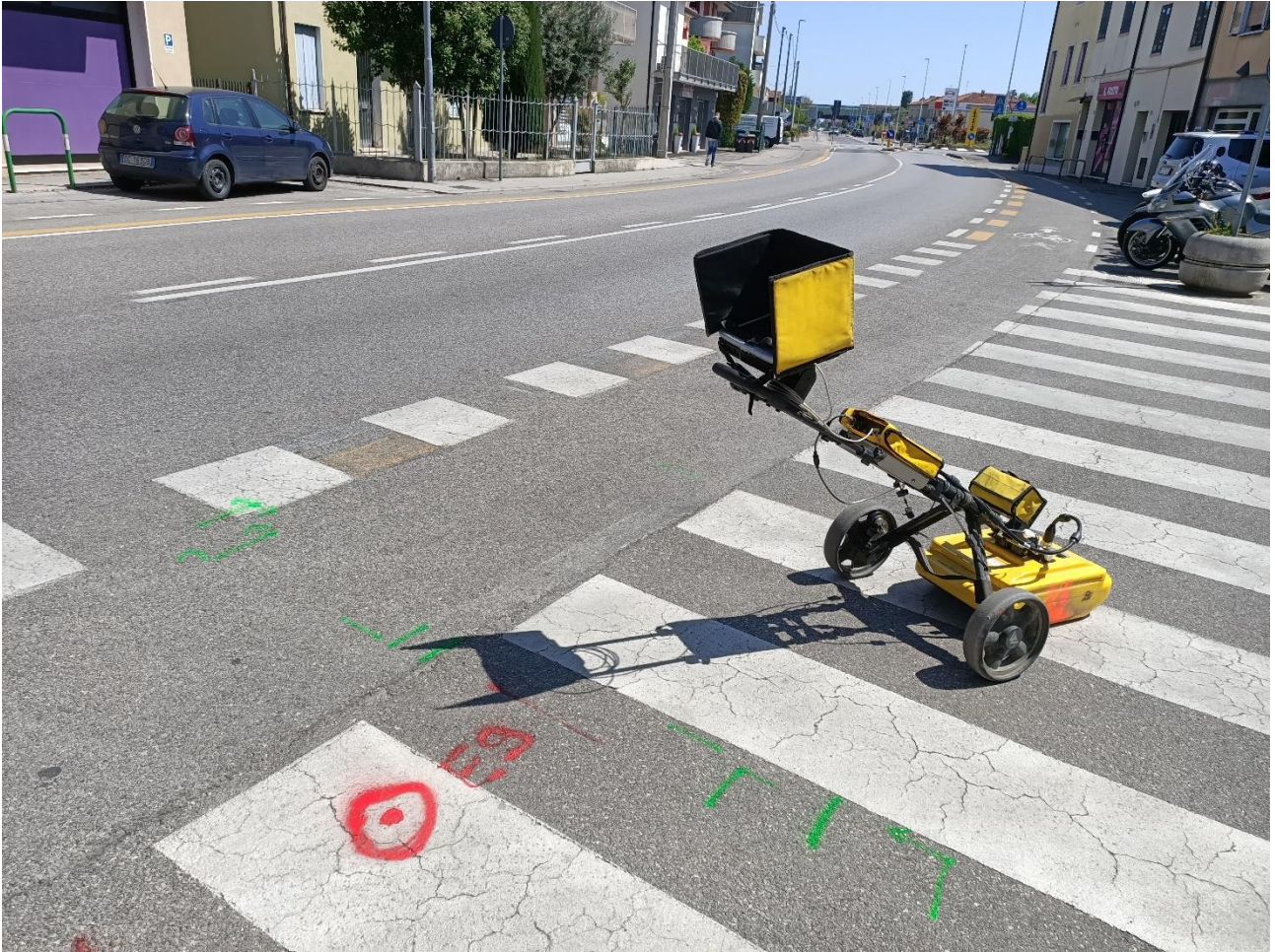
Figura 61 – Indagine georadar in corrispondenza del punto di indagine E9.
