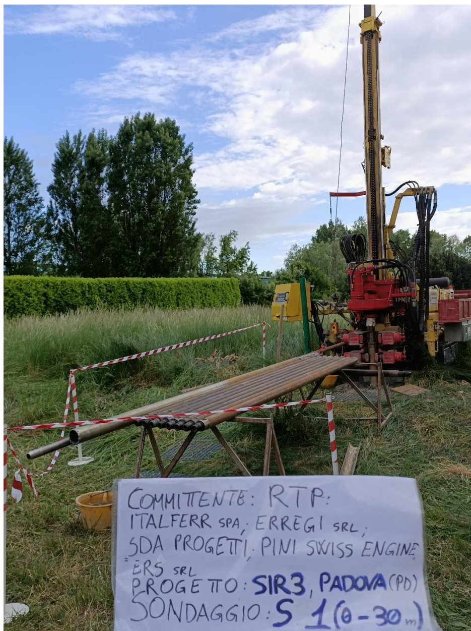
Figura 2 – Sonda approntata nel sondaggio S1
