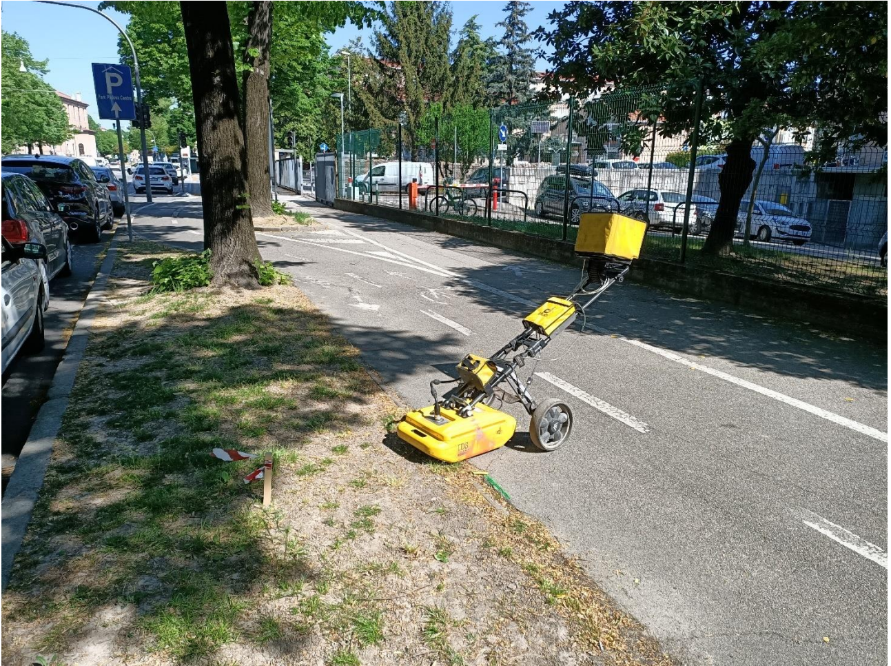
Figura 46 – Indagine georadar in corrispondenza del punto di indagine E4.
