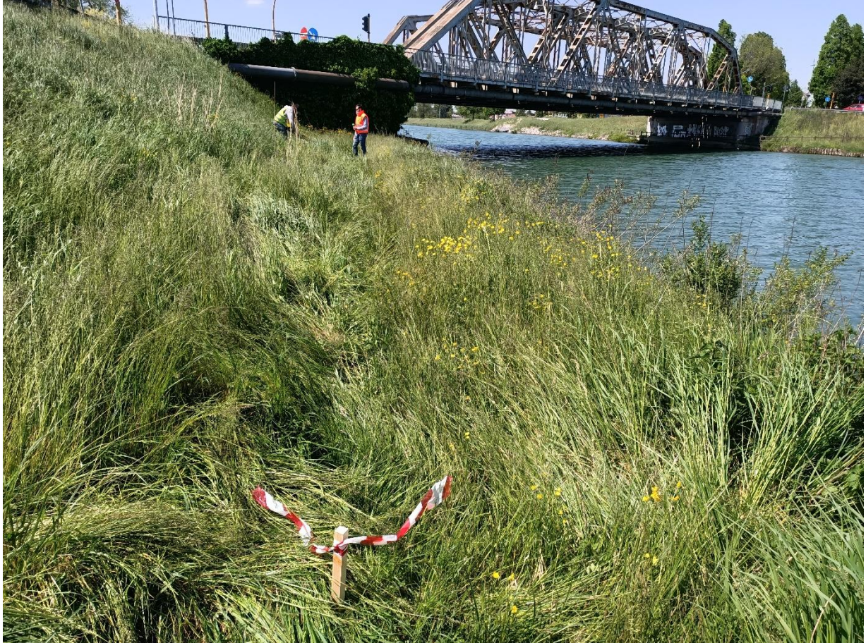
Figura 29 – Indagine georadar in corrispondenza del punto di indagine P3.
