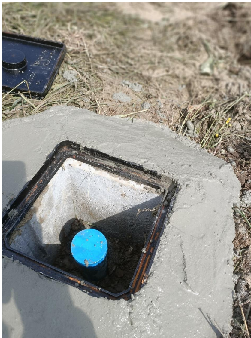
Figura 20 - Tubo piezometrico installato nel foro di sondaggio S3.
