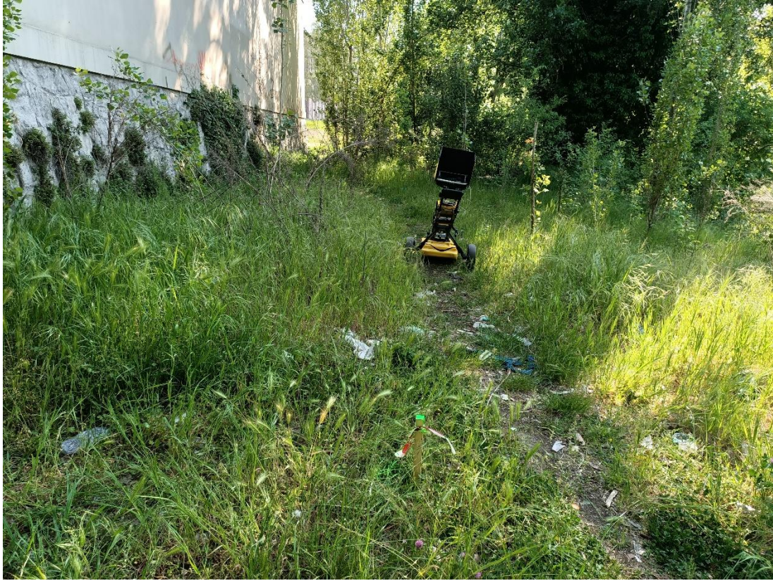
Figura 23 – Indagine georadar in corrispondenza del punto di indagine P1.
