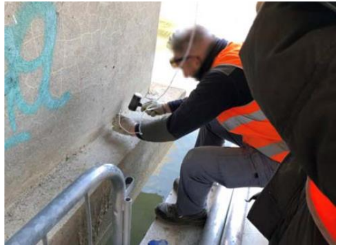
Figura 23 Prova ecometrica sui pali di fondazione
