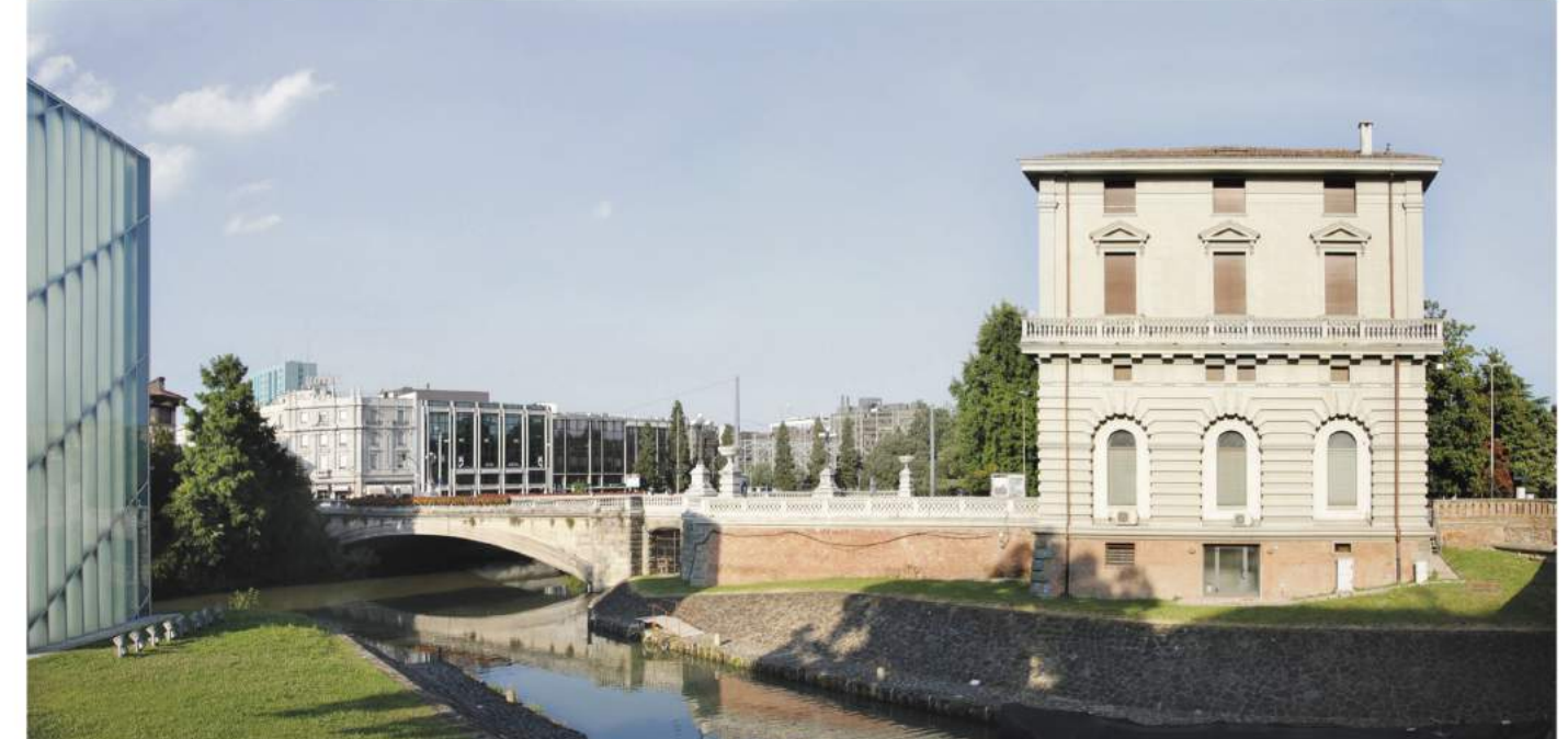
In corrispondenza delle spalle del ponte, sono visibili i due passaggi sotto l'impalcato, oggi chiusi.
