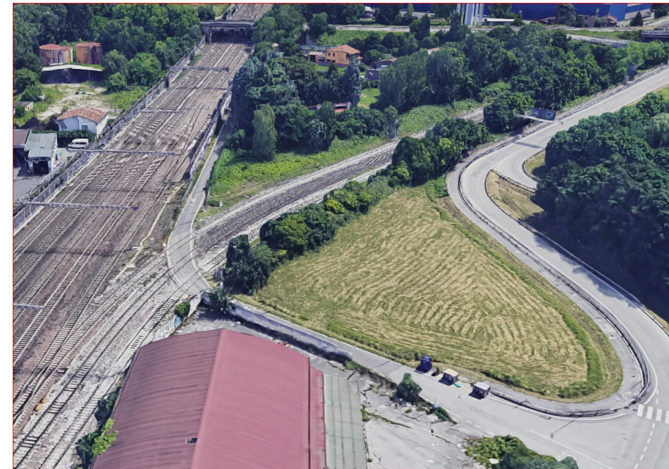
Vista dall'alto dell'attuale passaggio a livello da dismettere
