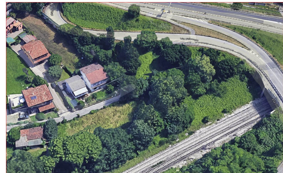
Vista dall'alto della zona oggetto dell'opera
