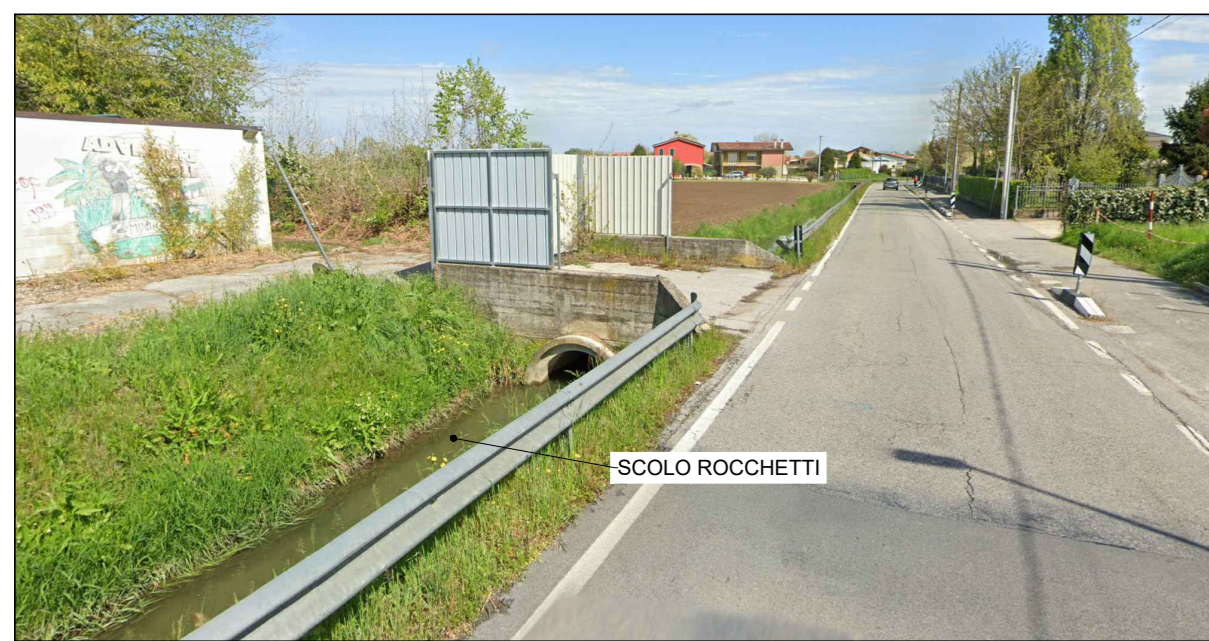
FOTO 2 - VISTA VERSO NORD SU LOTTO IN TRASFORMAZIONE
