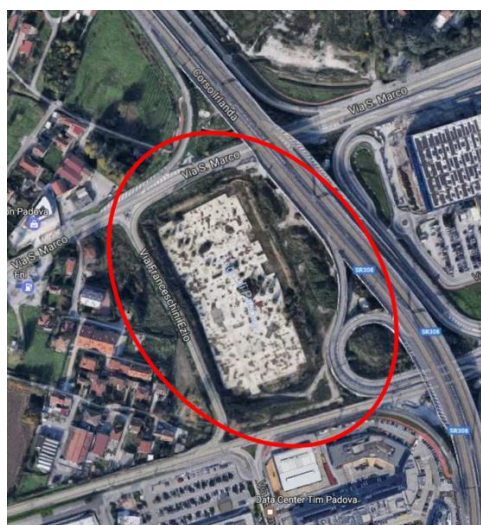
Localizzazione area PUA - PT2 (in evidenza i lavori per la realizzazione dell'interrato)
