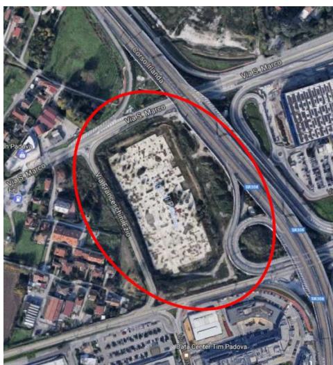
Figura 1 Localizzazione area PUA - PT2 (in evidenza i lavori per la realizzazione dell'interrato)
