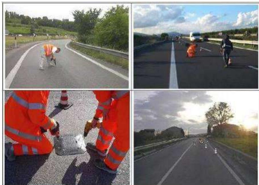
Figura 104 - Esempio installazione delle piastre
