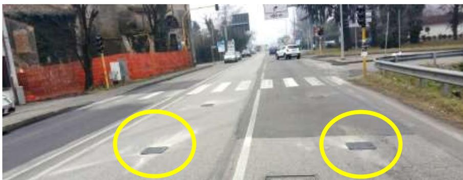
Foto 18 – Esempio installazione apparecchiature per rilievo automatico
