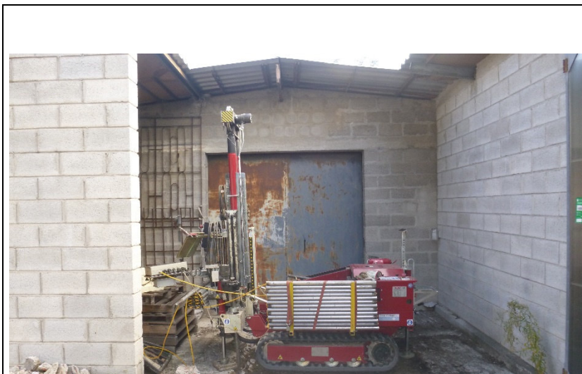
Foto 7: Esecuzione della prova CPTU7
