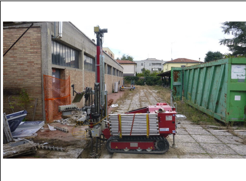
Foto 5: Esecuzione della prova CPTU5
