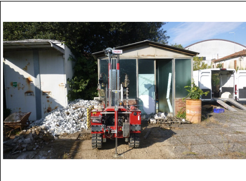
Foto 6: Esecuzione della prova CPTU6
