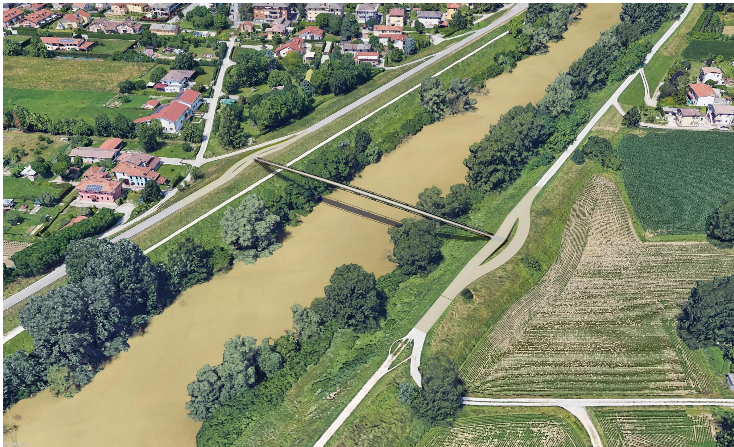
Figura 4 - vista verso ovest (da sponda sinistra)
