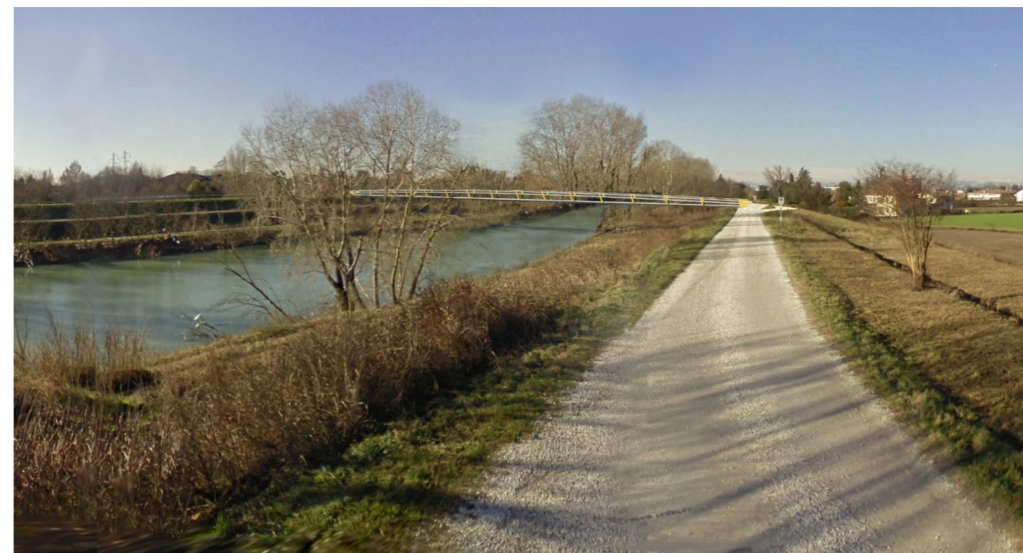
Figura 3 - cono visuale verso monte dall'argine sinistro con la passerella e il ringrosso arginale inseriti
