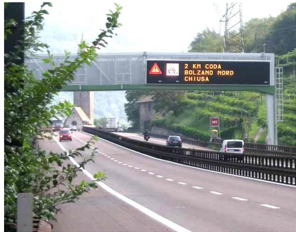
Esempio di pannelli a messaggio variabile (Fonte: [www.aesys.com](http://www.aesys.com))
