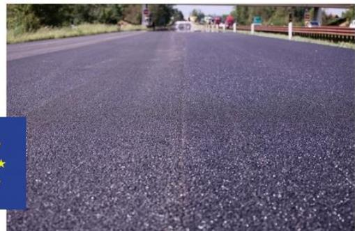
A sinistra, la caratteristica granulometrica dell'asfalto fonoassorbente. A destra, un esempio di asfalto fonoassorbente realizzato grazie all'aggiunta di polverino di gomma da pneumatici fuori uso al bitume (progetto Life Nereide "Noise efficiently reduced by recycled pavements" – rumore ridotto efficacemente con "asfalti riciclati"); tale asfalto può ridurre il rumore fino a 5 dB
