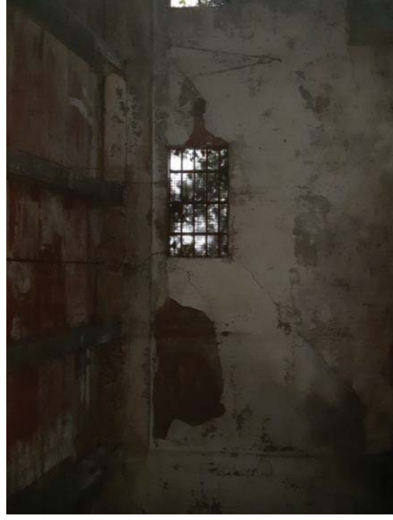
Particolari degli interni al piano terra (colonna centrale) e al piano primo (colonna di destra).
