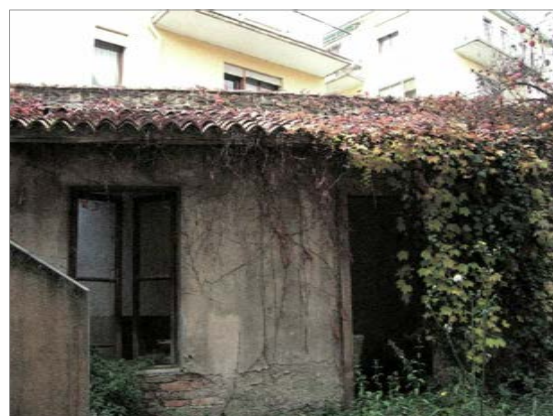
PIANO TERRA INGRESSO DEL MAGAZZINO
