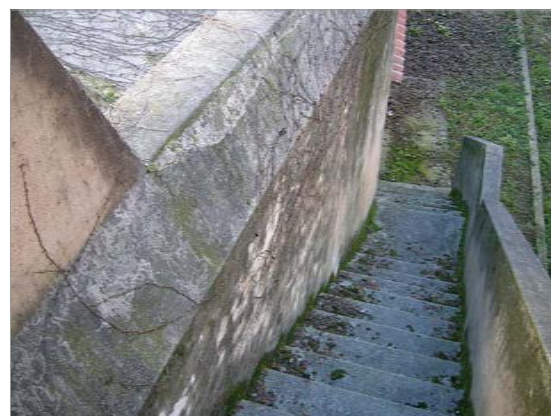
VISTA DELLA SCALA CHE PORTA AL MAGAZZINO
