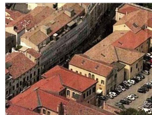
ALA SUD VISTA AEREA LATO NORD SU CORTE INTERNA
