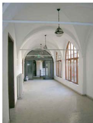
LOGGIATO PIANO TERRA
