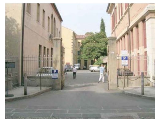
ALA SUD LATO EST INGRESSO CARRABILE
