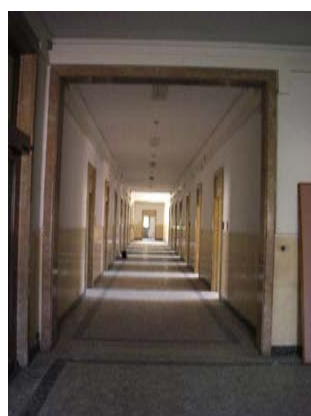
CORRIDOIO PIANO SECONDO
