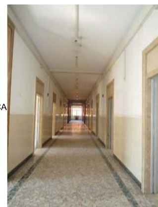
CORRIDOIO PIANO PRIMO
