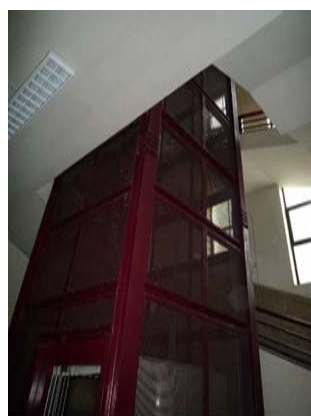
VANO SCALA E ASCENSORE
