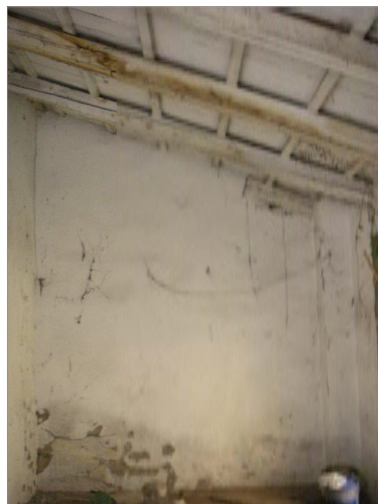
PIANO TERRA INTERNO DEL MAGAZZINO
