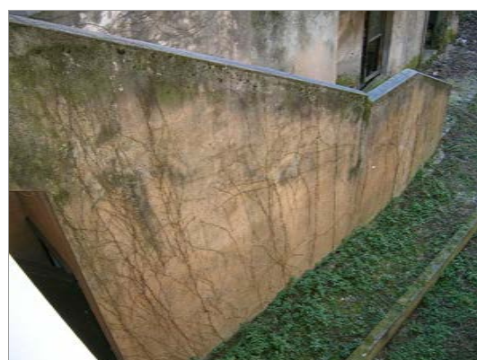
VISTA DELLA SCALA CHE PORTA AL MAGAZZINO
