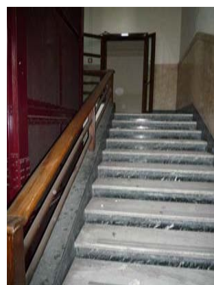
VANO SCALA E ASCENSORE
