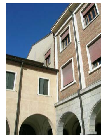
ALA NORD LATO SUD SU CORTE INTERNA ATTACCO CON ALA OVEST
