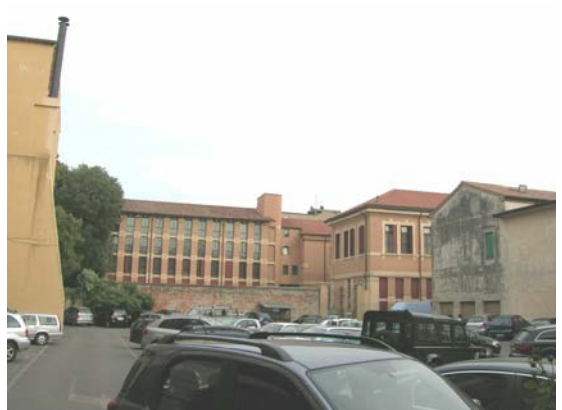
Vista verso l'ala Est, demolita nel 1969
