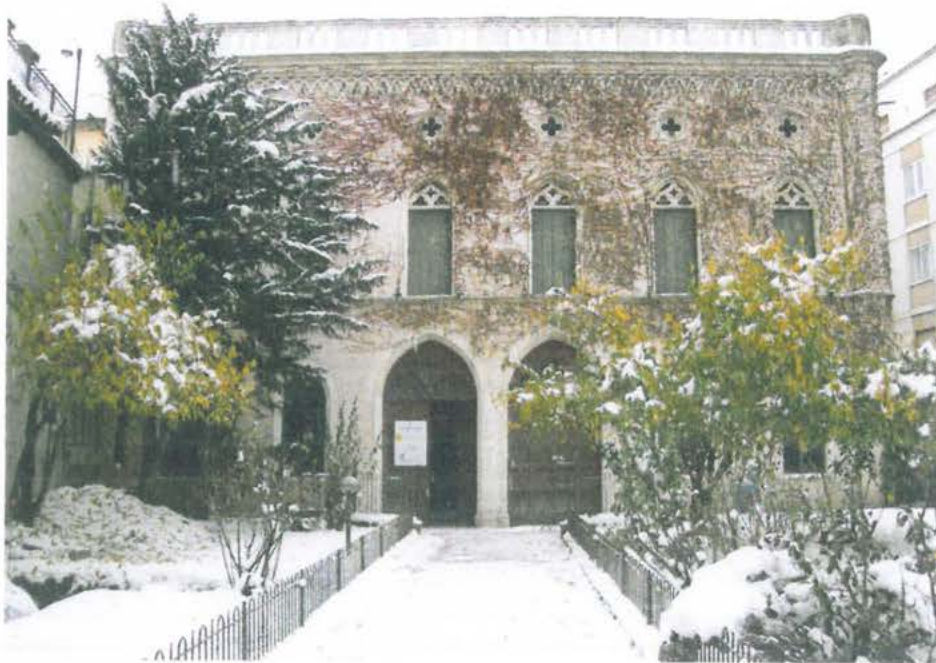
Figura 1 PD-via Zabarella- AREA GIARDINO: le trincee di scavo coperte dalla neve
