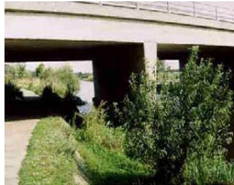
Attraversamento idraulico per il passaggio di una pista ciclabile e fauna
