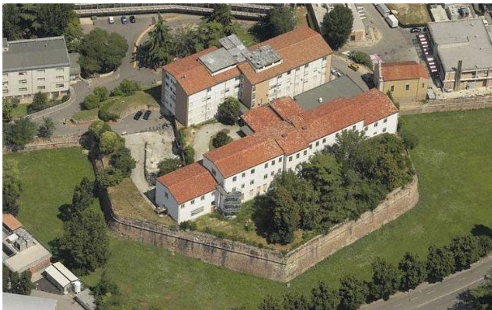
Veduta aerea del baluardo Cornaro sul quale sorge uno degli edifici ospedalieri (Fonte: http://www.muradipadova.it )
