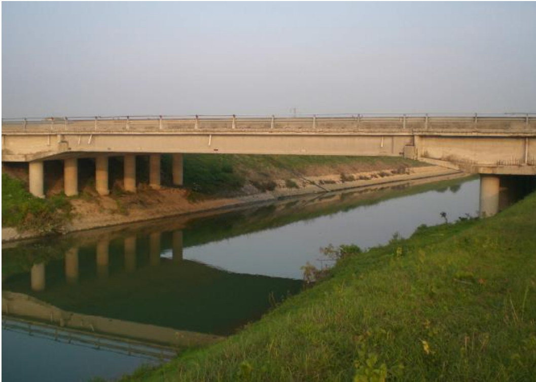
Figura 5.2 – Ponte Autostrada A13 sul canale Piovego a Noventa Padovana.
