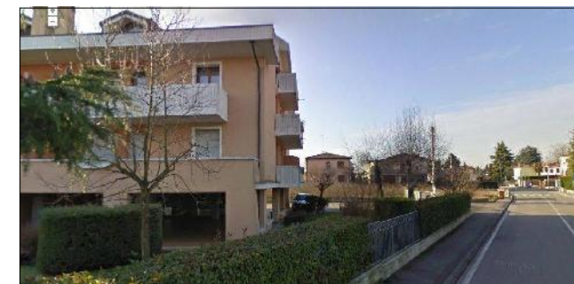
PARTICOLARE AREA SKYLINE B
