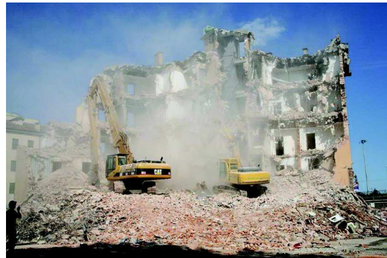
D.L.L. CSE Demolizione edifici
